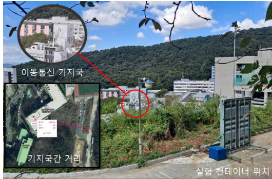
그림 6. 이동통신 기지국간 거리 Fig. 6. Distance between mobile communication base stations
