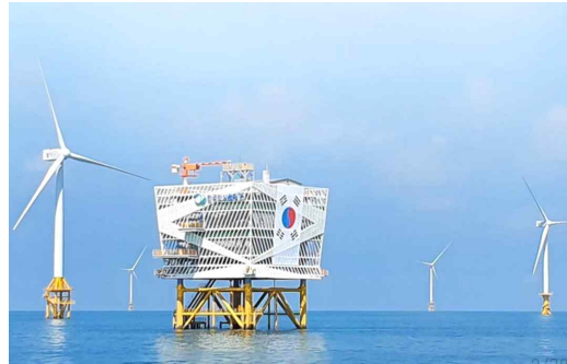
[한국해상풍력 서남해 실증단지 60MW 전경]
