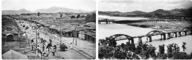
<그림 5> 조선 후기 종로 <그림 6> 한강철교, 1900년 7월 준공, 2006년 6월 대한민국의 국가등록문화재 제250호로 지정
