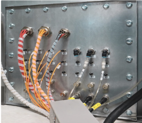
그림 3. 통신 필터 패널 Fig. 3. Communication Filter Pannel
