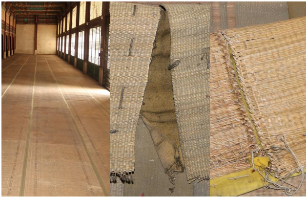
그림 4. 창덕궁 신선원전 지의의 전경(좌)과 하배 지의의 연폭부(중) 및 상배 지의의 연폭부(우)
