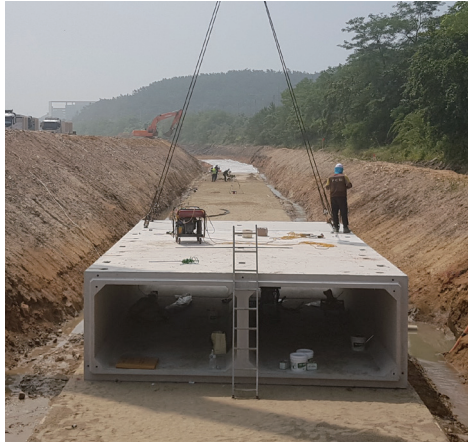
그림 1. 본 기술이 적용될 콘크리트 암거
