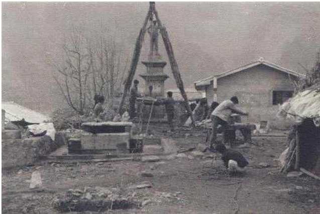
그림 6. 이마대(이각대)를 이용한 석탑 수리
