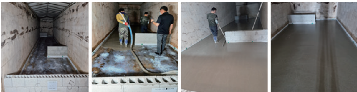
그림 6. 바닥수평조절용 건조물탈 평활도 검증 Mock up
