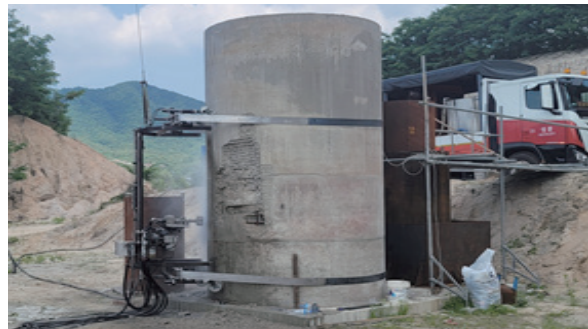
그림 5. Mock-up Test 전경
