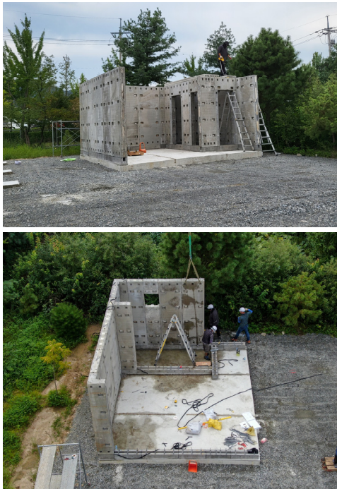
〈Fig. 2〉 BPC 시스템의 시공 모습 6
