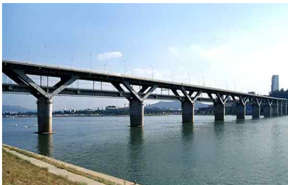
그림 1. 강철도 복합교량 전경 Figure 1. Photograph of railway steel composite bridge
