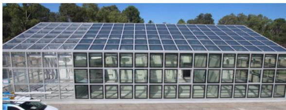
그림 4. 70% 가시광투과율, 30W/m<sup>2</sup> 출력의 LSCs 기반 창호로 구성된 ClearVue사의 PV 유리온실 실증사례, 2021.4. (source: ClearVue)<sup>[11]</sup>
