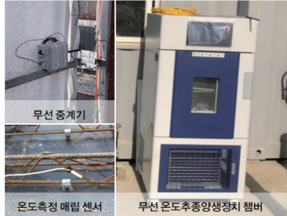
사진 3. 무선 온도추종 양생시스템
