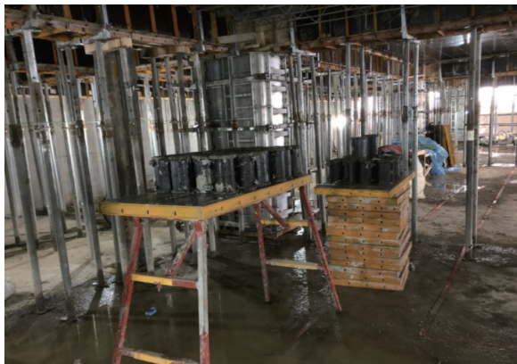
사진 2. 조강축진 콘크리트 현장 공시체 양생 전경
