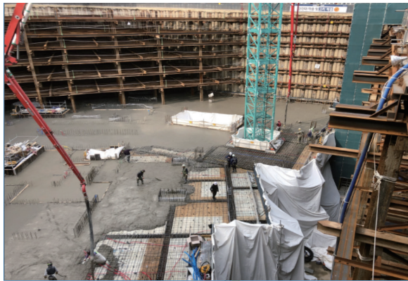
사진 1. 조강축진 콘크리트 현장 시험적용 전경
