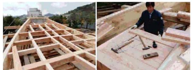
그림 4. 마도 1호선의 복원 건조 중, 귀틀 설치(좌) 및 갓판(갓판) 설치(우)
