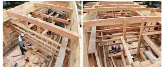
그림 3. 마도 1호선의 복원 건조 중, 가름 및 머미 설치(좌)와 내부구조물 설치(우)
