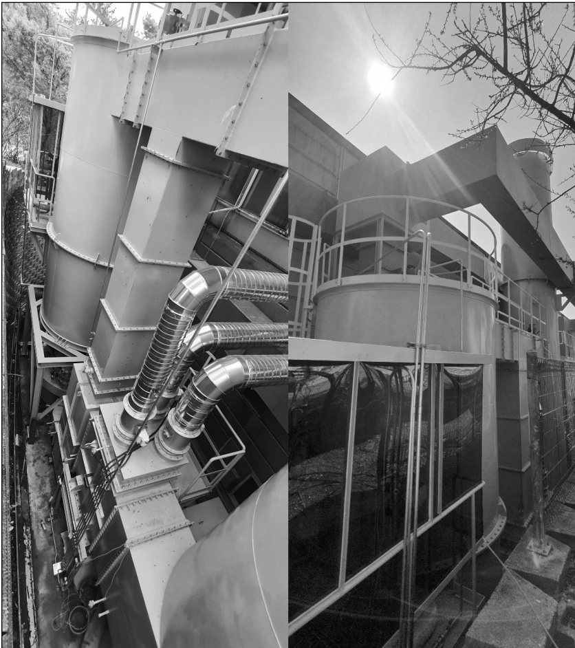
▲ 신명이노텍(대표이사 문근식)이 지난해 10월 15일 한국환경공단과 업무협약을 맺고 진행한 스마트생태공장 구축사업이 성공적으로 마무리했다. 축열식 연소산화장치를 도입, THC를 99% 이상 제거할 뿐만 아니라 연소 이후 발생하는 폐열 에너지의 재사용으로 에너지 절감 효과를 거두는 것에 성공했다.
