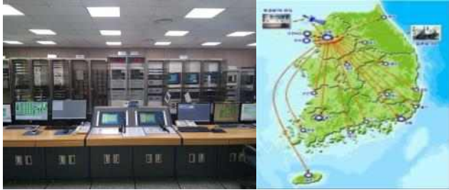
그림 3. 음성통신제어장치(김포공항) 및 항공고정통신망 Fig. 3. Voice communication control system and aeronautical fixed telecommunication network
