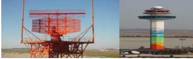
그림 2. 공항감시레이더 및 지상감시레이더 시설 Fig. 2. Airport Surveillance Radar and Surface Movement Radar
