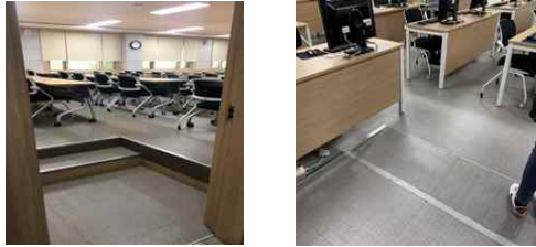
(a) 단차를 제거하거나 완화하지 않은 사례 (b) 경사로 설치로 단차를 제거한 사례
