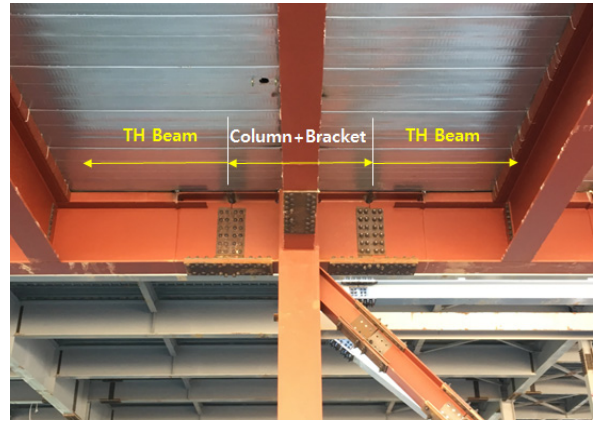
〈Fig. 5〉 Detail of rigid connection
