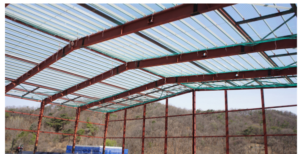
〈Fig. 14〉 Installed TH Beam (Span : 48m)
