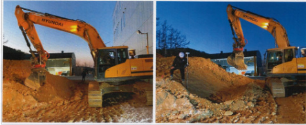
<기존 시공 방법 VS Machine Control System>
