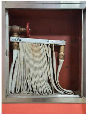
[Figure 3] Hose hanger-type
