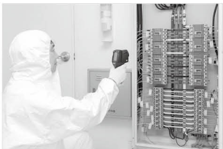
〈정전대비 전기 시설 점검〉
