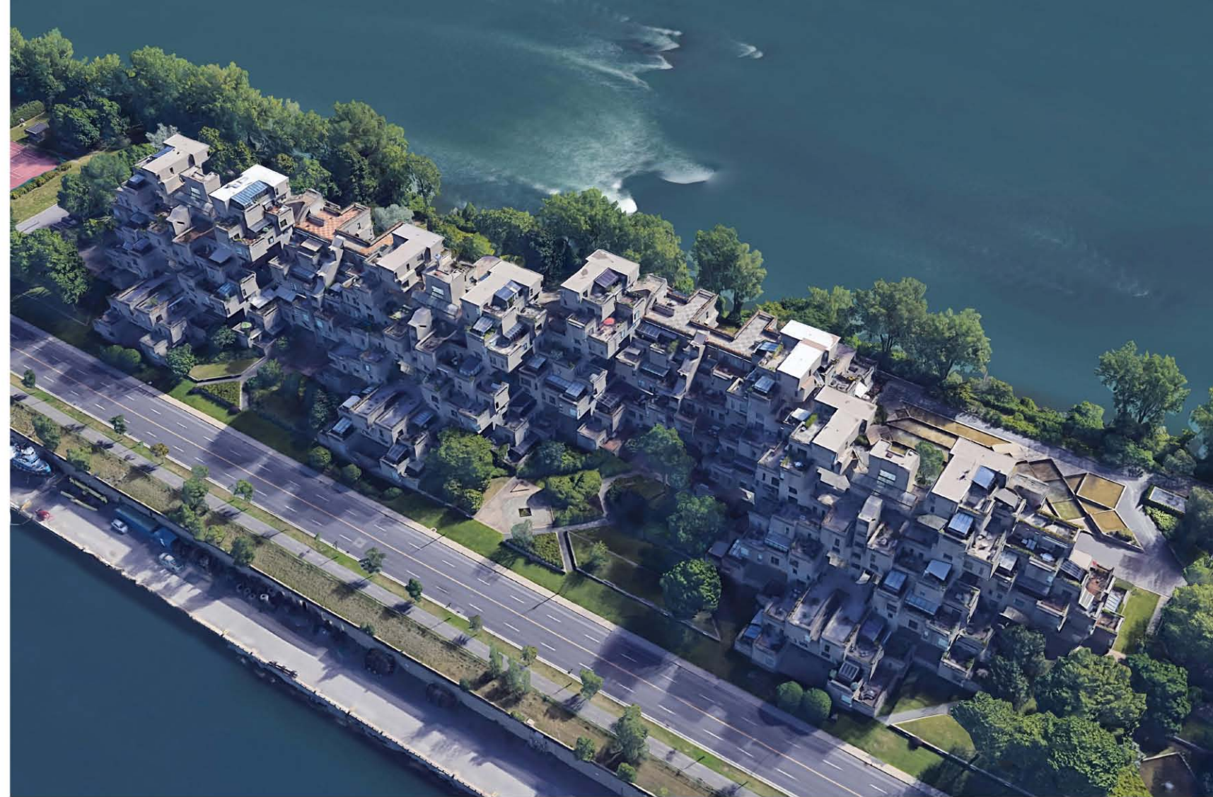
모쉐 샤프티가 디자인한 '몬트리올 해비타트' 캐나다 몬트리올에 가면 1967년 몬트리올 엑스포를 기념해서 만든 '해비타트 67'이라는 아파트가 있다. 총 15가지의 유닛이 다양한 형태로 조합을 이루면서 158가구를 구축한다. 365개 모듈러들은 공장에서 미리 만들어진 콘크리트 구조체이다. © Google Earth
