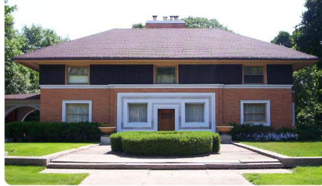
프랭크 로이드 라이트가 애들러 & 설리번 사무실에 근무하던 시절 디자인한 월터 게일 주택은 퀴엔 양식으로 디자인되었다.
