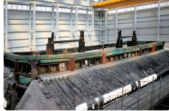
복원 공사 중 송례문(2008)
