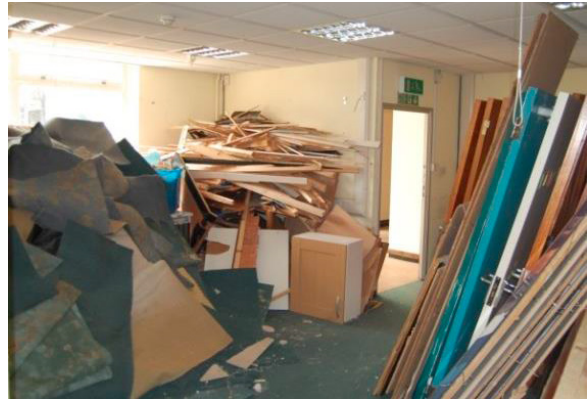
그림 1. 철거 현장의분별 해체 모습
