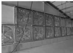
육계사 환기팬 설치
