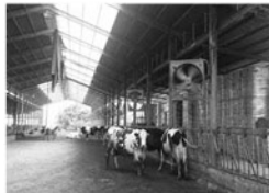
우사 송풍팬 설치
