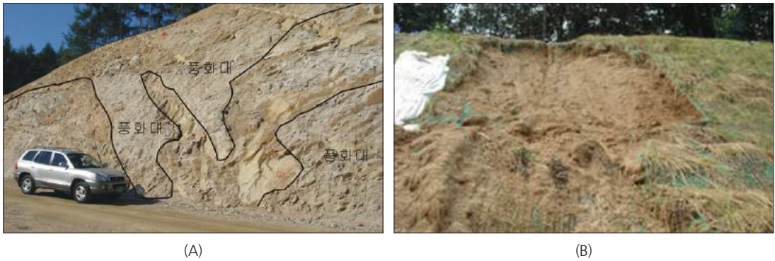
그림 5. 화강암의 사면에서 보이는 불규칙한 풍화대의 경계면(A)과 집중호우에 의해 붕괴된 사면(B)
