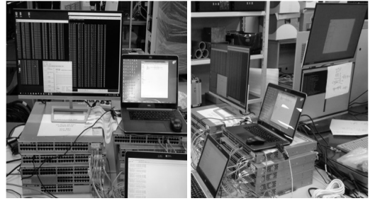
그림 10. 절체 성능 시험 환경 Fig. 10 Test environment of fail-over performance test
