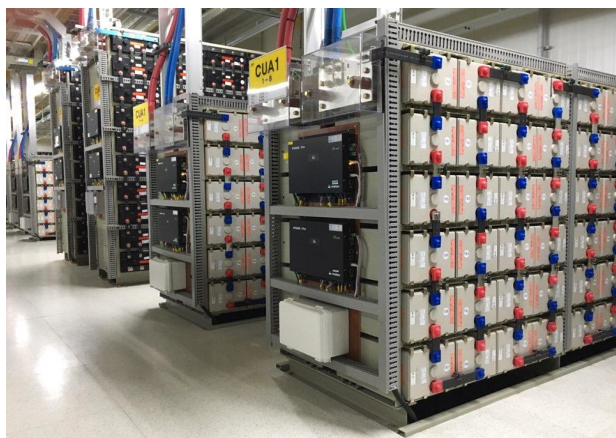
Fig. 6. Installation of BMS at IDC site. 그림 6. IDC 센터 BMS 설치 사진
