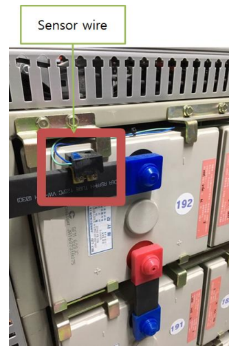
Fig. 7. Sensor wire connection to battery busbar. 그림 7. 배터리 부스바 연결 센서선
