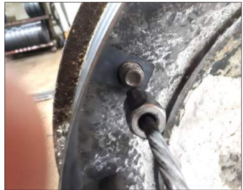
그림 2. PC너트와 마구리판이 인장 볼트로 체결되는 모습
