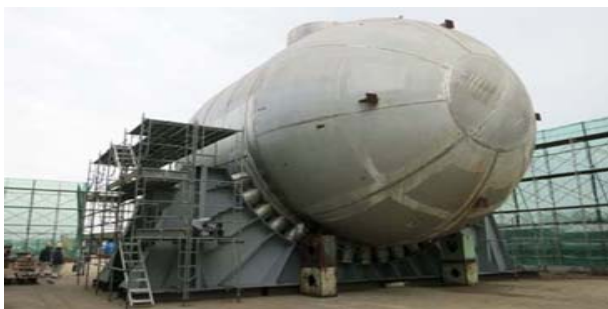
그림 8 실린더형 유리섬유강화 플라스틱 지지대가 적용된 목업(Mock-up) 액화수소 저장탱크
