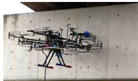
〈Fig. 7〉 Crack check by drone
