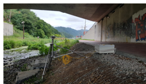
(D) Concrete bridge
