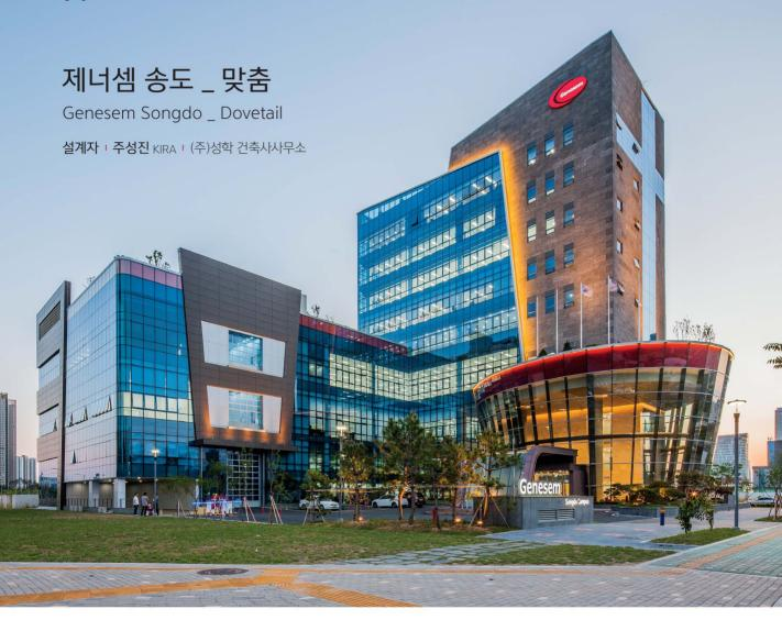
건축주 제너셈 주식회사 / 감리자 (주)성학 건축사사무소 / 시공사 현해건설 주식회사 / 설계팀 차윤선, 고상원 / 대지위치 인천광역시 연수구 송도과학로84번길 24 / 주요용도 교육연구시설(연구소) / 대지면적 4,756.20㎡ / 건축면적 2,469.91㎡ / 연면적 14,058.15㎡ / 건폐율 51.93% / 용적률 219.08% / 규모 지하 1층, 지상 9층 / 구조 철골철근콘크리트조 / 외부마감재 화산석, 접합강판, 스틸커튼월, 로이유리 / 내부마감재 대리석, 수성페인트, 알미늄루버 / 설계기간 2013. 01 ~ 2013. 03 / 공사기간 2014. 03 ~ 2016. 11 / 사진 최정복 / 구조분야 (주)더나은구조엔지니어링 / 기계설비분야 주식회사 평상 / 전기분야 (주)신한이엔씨 / 소방분야 (주)한백에프앤씨
