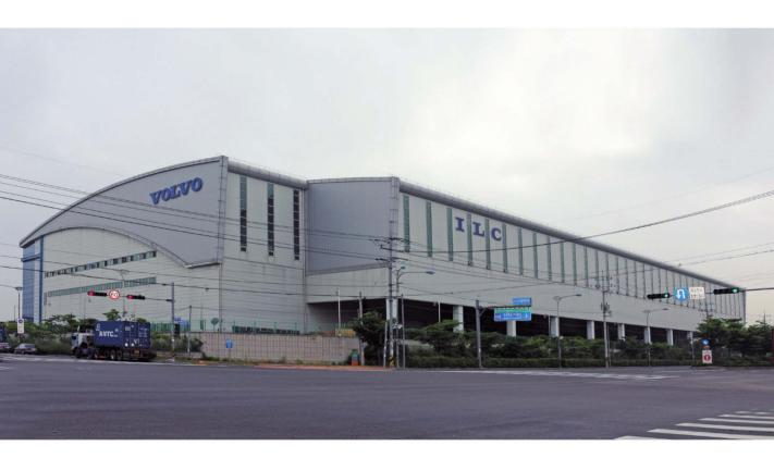
건축주 박원복 \_ (주)아이엘씨 / 감리자 신중식 \_ (주)머지 건축사사무소 / 시공사 박원복 \_ (주)일류종합건설 / 설계팀 l 김승철 / 대지위치 인천광역시 중구 신흥동3가 39-29 / 주요용도 창고 / 대지면적 23,141.00㎡ / 건축면적 13,665.91㎡ / 연면적 30,037.19㎡ / 건폐율 59.05% / 용적률 129.80% / 규모 지상 1층 / 구조 철골조, 철근콘크리트조 / 외부마감재 그라스울판넬, 알루미늄복합판넬, 아연도칼라강판, 뉴트라 지붕 슬라이딩 시스템, 반사복층유리, 알루미늄 시트 / 내부마감재 데코타일, 침투성 콘크리트 표면강화제, 화강석물갈기 / 설계기간 2016. 06 ~ 2016. 11 / 공사기간 2017. 02 ~ 2017. 08 / 사진 석진수 / 구조분야 (주)센구조연구소 / 기계설비·전기·소방분야 (주)하나설비설계사무소
