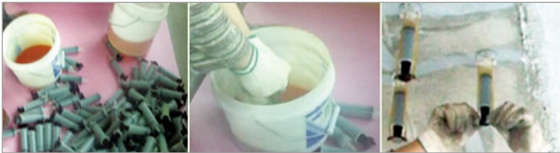
<그림 3> 에폭시 그라우트재 주입 작업
