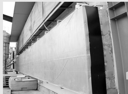
개방계사의 경우 측면 커튼의 개폐를 통해 자연 환기를 시키게 되는데, 최적의 계사 내부 환경을 만들어주기 위해서는 내·외부의 온도와 습도, 풍속, 풍향을 고려하여 커튼을 조절해 주어야 하므로 세심한 관찰과 지속적인 관리가 필요하다. 추가로 순환 팬을 설치하여 여름에 체감온도를 낮춰주거나 겨울에 유입되는 찬 공기를 내부의 따뜻한 공기와 섞어줄 수 있다. 무창(환경조절)계사는 배기팬을 설치하여 강제 환기를 시키는데, 계사 규모 및 구조와 사육 수수 등을 고려하여 적정한 수의 배기팬을 설치하고 입기구의 면적을 맞춰주어 적절한 음압이 유지되어 계사 전체에 고르게 일정 속도 이상의 풍속이 발생하도록 해야 한다.
