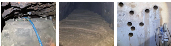
그림 5. 폐갱도에 기포-CLSM의 타설 및 코어 채취
