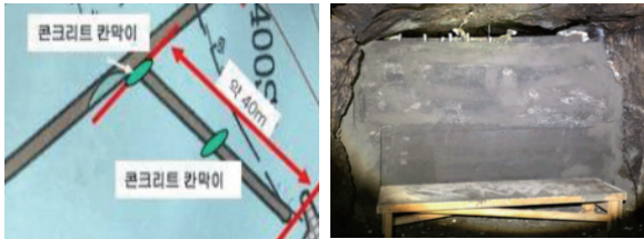
그림 4. 폐갱도 콘크리트 차수벽 설치
