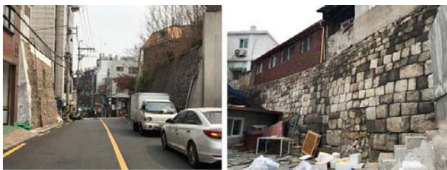
(가) 장충단로8길 (나) 훼손된 한양도성 위 주택 그림 28. 한양도성 훼손 후 도로 개설 및 주택 신축
