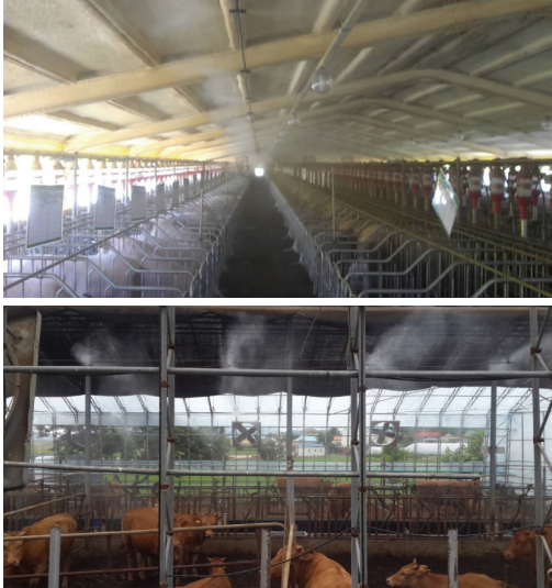
그림 1. 분무시스템을 통하여 축사 내 분진제거 시스템
