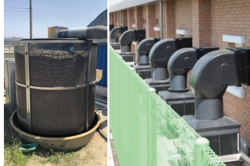
그림 3. 바이오 필터를 이용한 축사에서 배출되는 악취 제거 시스템
