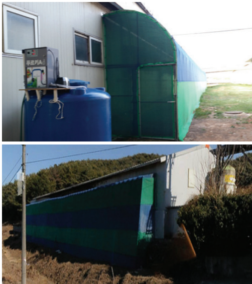
그림 2. 바이오 커튼을 이용한 축사에서 배출되는 악취 제거 시스템
