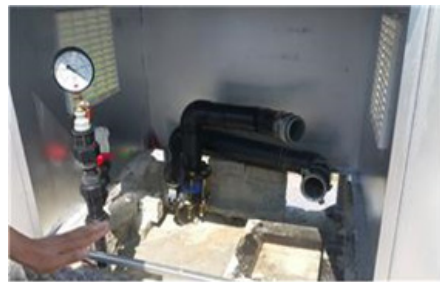
(d) Air vent tube installation
