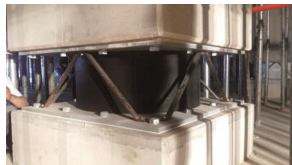
<Fig. 4> LRB(Lead Rubber Bearing) 7)
