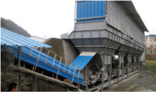
(b) 콜드피더 및 컨베이어 지붕 설치
