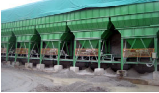
(a) 콜드 빈 지붕 설치
