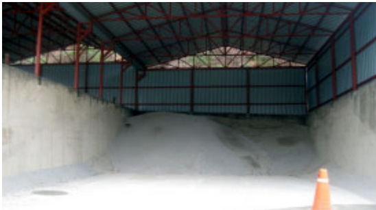
(b) 잔골재 저장소 지붕 설치
