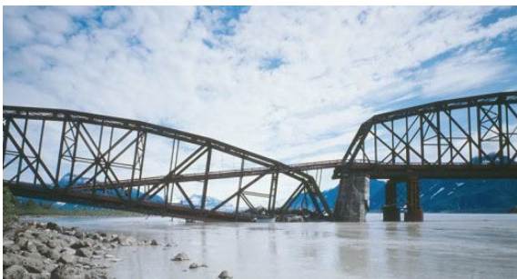
〈Fig. 2〉 Collapse of structure
