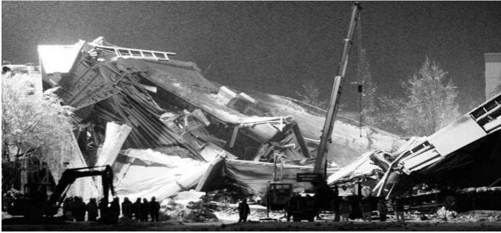
사진 4. 폭설에 의해 무너진 바트 라이헨할 아이스링크 출처 : DEVASTATING DISASTERS(2016)
