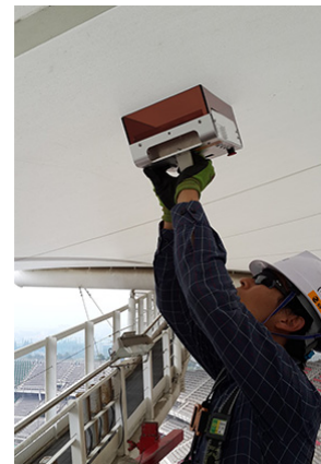
〈Fig. 9〉 Measurement display; under the membrane
