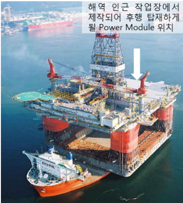
그림 1 Power Module의 후행탑재가 이루어진 BP Thunder Horse PDQ
