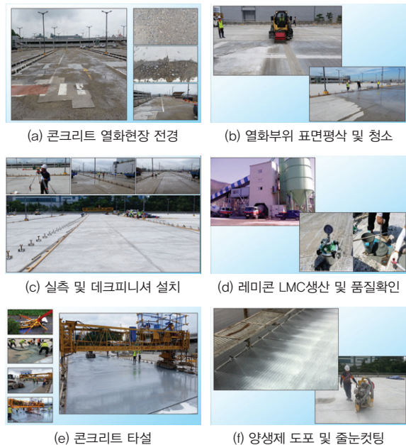
사진 2. 레미콘 LMC의 시공절차
