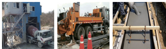
사진 3. K-UHPC의 레미콘 B/P 제조 및 펌핑 타설 모습
