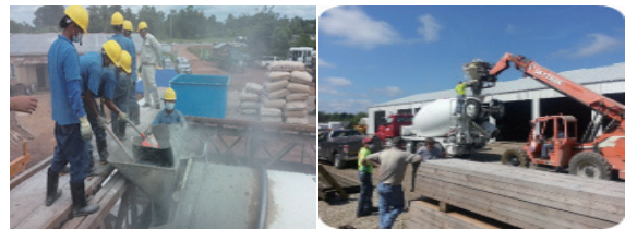
사진 2. 레미콘 트럭으로 K-UHPC의 제조(미얀마, 미국)
