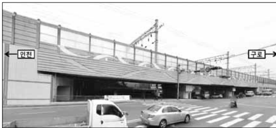
그림 4. 터널 상부 경인선 철도 축현교
